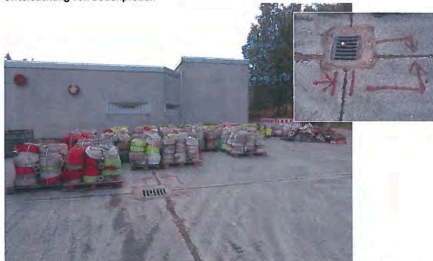
Abb. A15: Großes Bild: Übersicht des Bodenprobennahmeorts (Probe 4) bei Geb. 553. Kleines Bild zeigt die für die Probe herangezogene Fläche, hier die Stoßkanten der Betonplatten.
