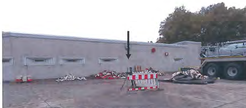
Abb. 20: Aufstellungsort der ersten In-situ-Gammaskopie (schwarzer Pfeil: Falcon 5000 HPGe-Detektor auf Dreibeinstativ mittig hinter Absperrung) nördlich Geb. 553. Die Aufstellung des Systems erfolgte unmittelbar am Gully und mit relativ gleichen Abständen zu den einzelnen Schlauchhaufen. Im Hintergrund sind die im Messzeitraum gelagerten, während des Moorbrands benutzten Schläuche zu erkennen.
