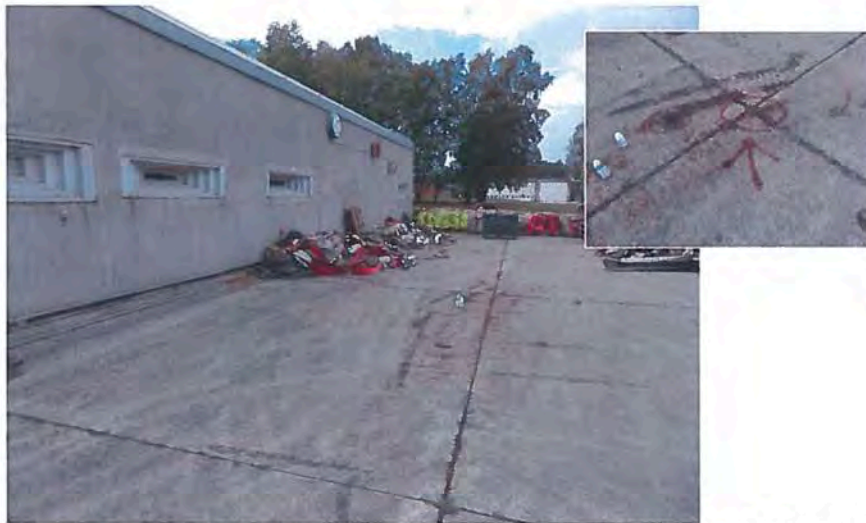
Abb. A16: Großes Bild: Übersicht des Bodenprobennahmeorts (Probe 2) bei Geb. 553. Kleines Bild zeigt die für die Probe herangezogene Fläche, hier die Stoßkanten der Betonplatten und Erdhaufen daneben.
