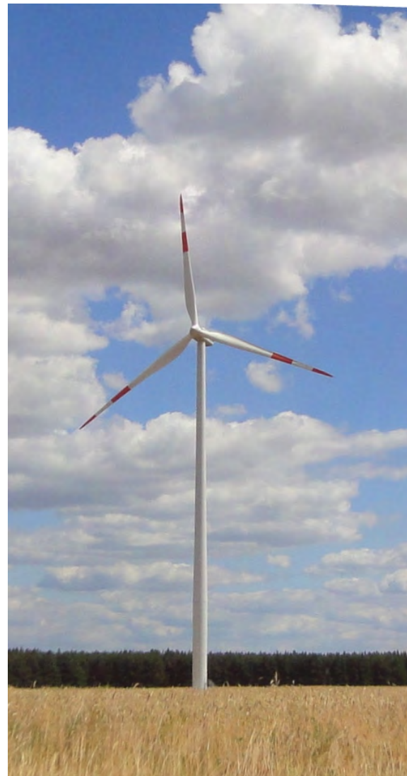
Abb. 13: Windkraftanlage der 2 MW Klasse.
