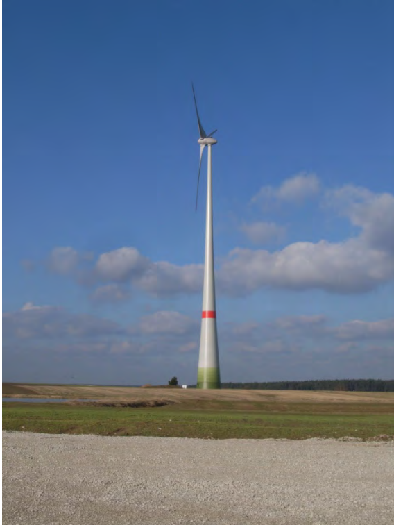
Abb. 6: 2 MW Windkraftanlage mit 138 m Nabenhöhe.
