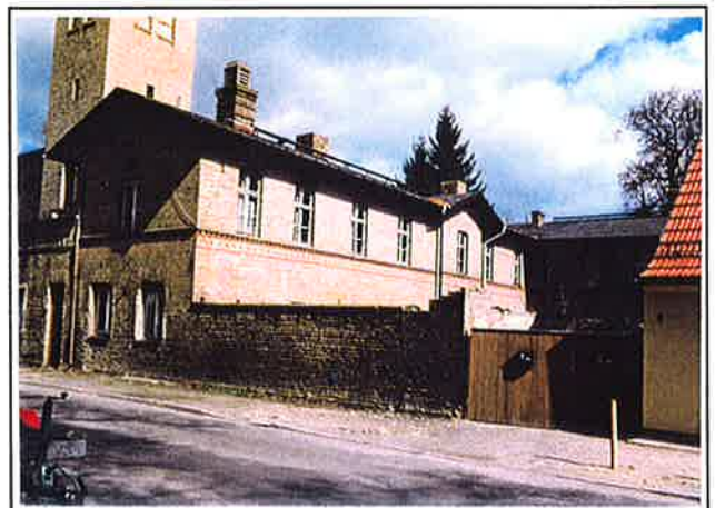
4.13.2 Typische Rohziegelmauer
