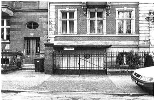
Tiefgaragenzufahrt: Trennung vom öffentlichen Straßenraum durch ein Tor, Markierung der Zufahrt im Gehweg durch Materialwechsel
