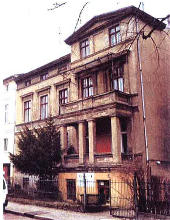
Typische Kragdachkonstruktion über Balkon
