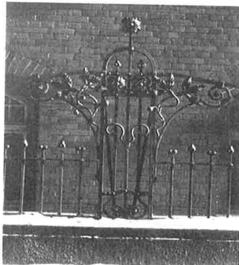
Einfriedung mit floralen Schmuckelementen, Gliederung in drei Zonen (Sockelzone, mittlere Zone, Abschlusszone)
