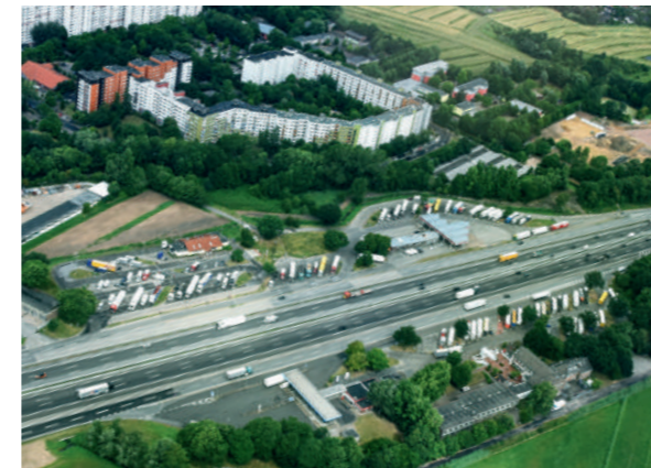
Die Anschlussstelle Hamburg-Stillhorn wird mit der neu entstehenden A 26 zum Autobahndreieck Südereibe ausgebaut.
