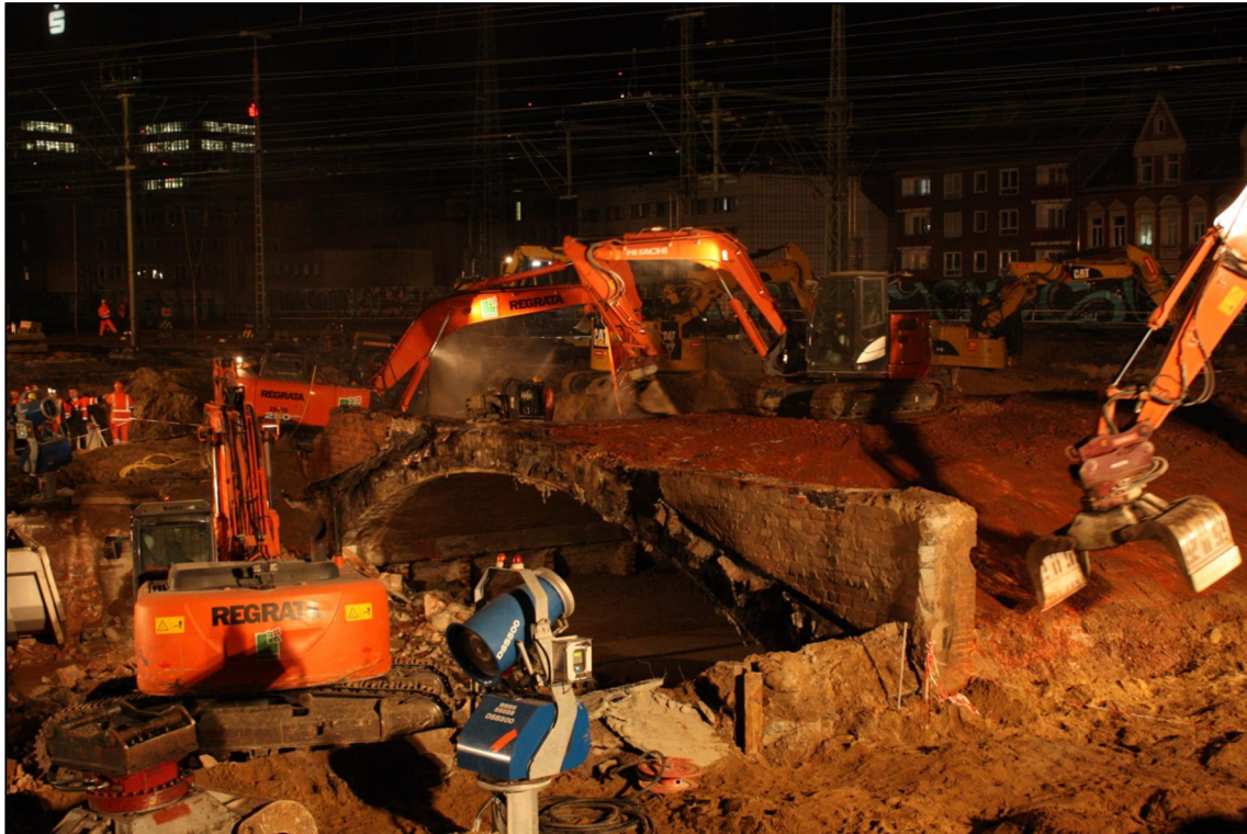
Abbildung 8: Sprühnebelkanone zur Niederschlagung von Staub und anderen luftgetragenen Schadstoffen und Gerüchen (Quelle: Mull und Partner, 06.10.2018)
