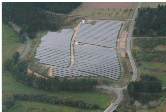
Abbildung 29: Ansicht der Photovoltaikanlage Kautendorf (QUELLE: LRA HOF)
