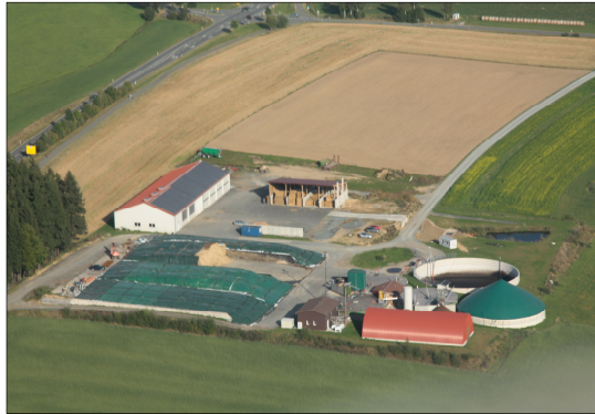
Abbildung 26: Ansicht der Biogasanlage Meierhof bei Münchberg (QUELLE: LRA HOF)
