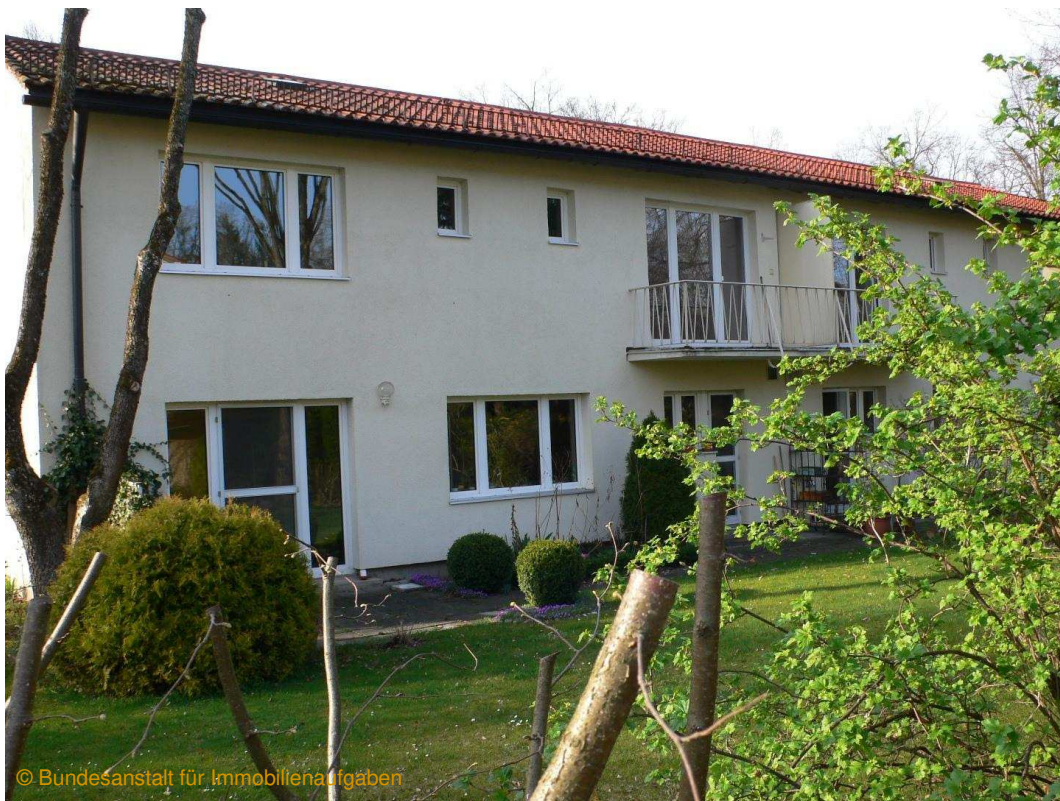
Rückansicht des Gebäudes
