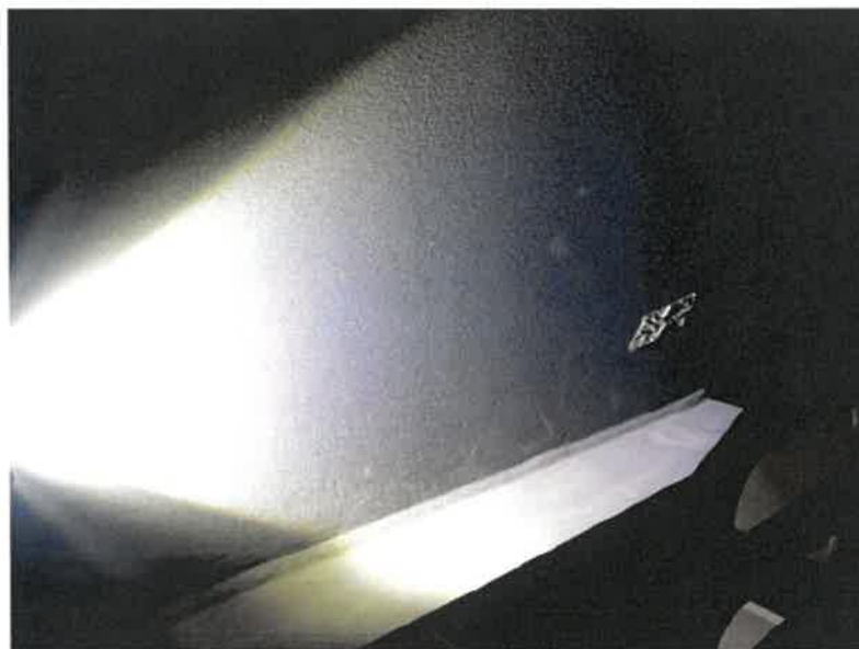
Abb. 4, Bereich TDG 123 - TDG 124 / Beispiel Overspray
