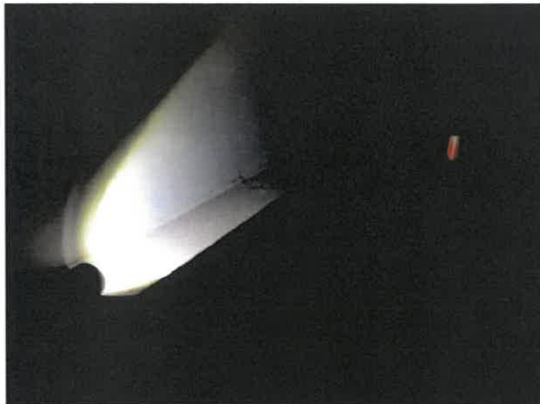
Abb. 8, Bereich TDG 127 - TDG 128 / Beispiel Overspray
