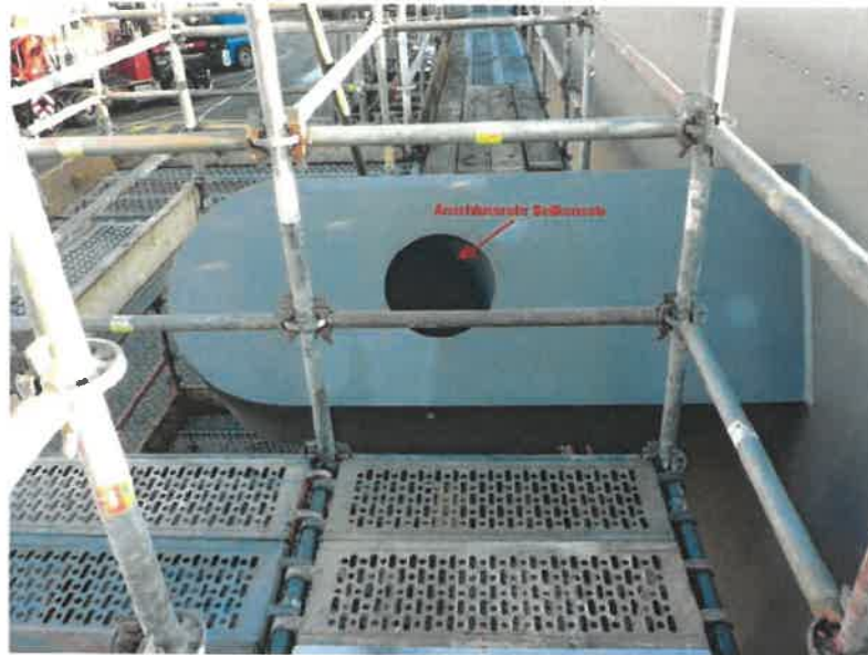
Abb. 4, Übersicht Anschlussrohr Seilkonsole TDC 41 und TDC 42
