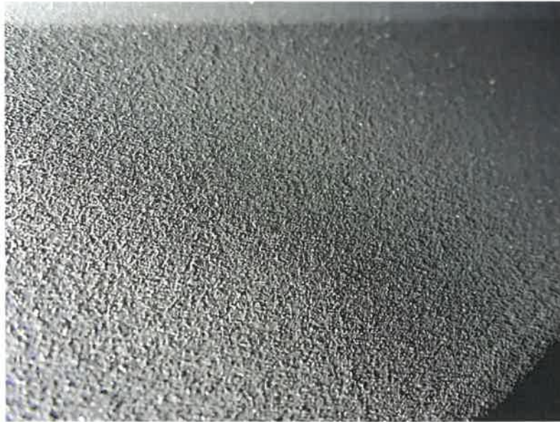
Abb. 9, Bereich TDG 127 - TDG 128 / Beispiel Overspray
