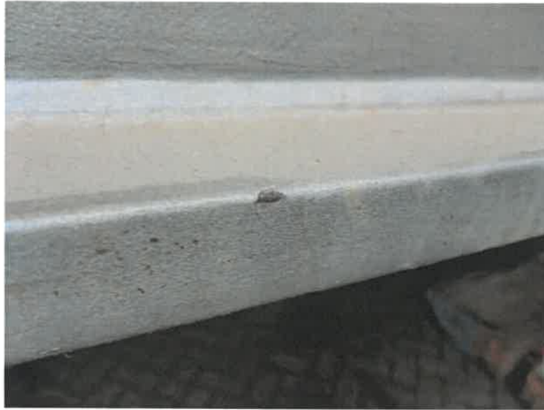
Abb. 21, Bereich DW1 außen / Anhang 4, Position 9
