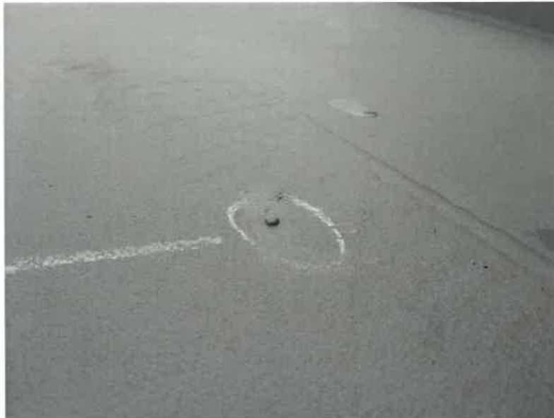
Abb. 13, Bereich TDC 41 außen / Anhang 4, Position 6a
