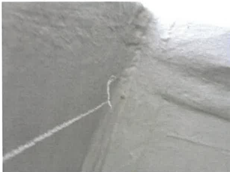
Abb. 14, Bereich TDC 41 außen / Anhang 4, Position 6b
