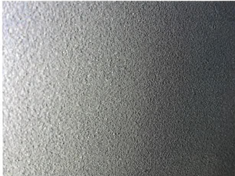
Abb. 7, Bereich TDG 125 - TDG 126 / Beispiel Overspray
