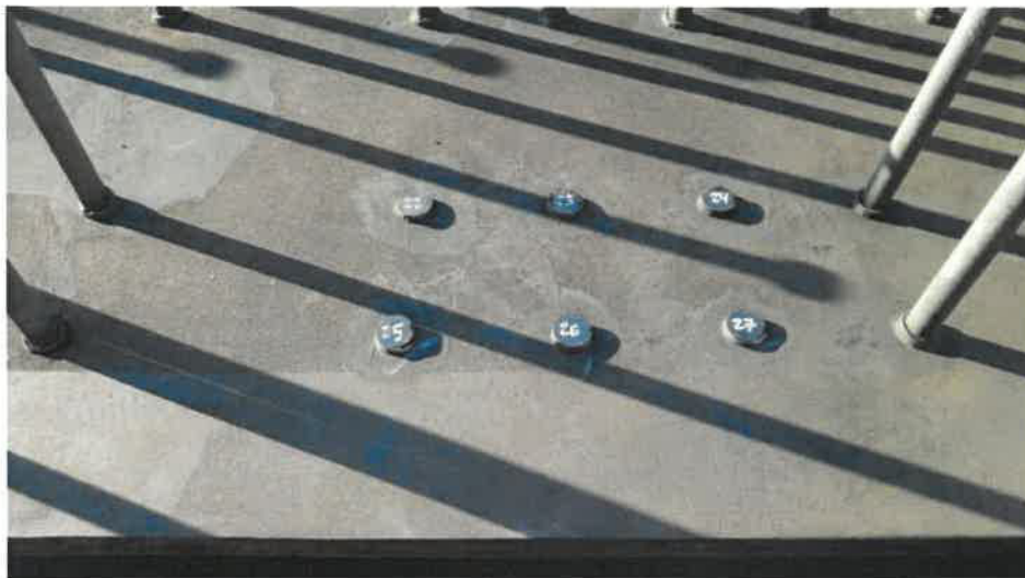
Bild 5 (T34A: Detail Bolzen Nr. 22 bis 27)
