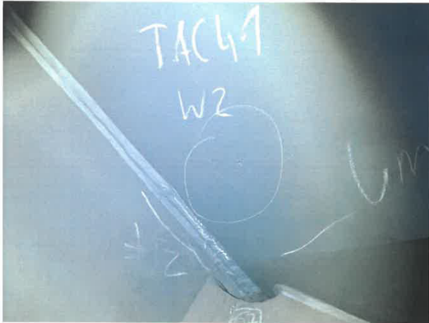
Bild 28 (Prüfpunkt 67 – Übersicht horizontale Längssteife an Stegblech W2 und TAC 41)
