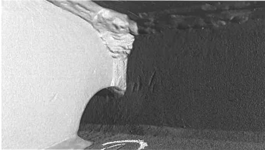
Bild 94 (Detail Prüf- punkt 104)
