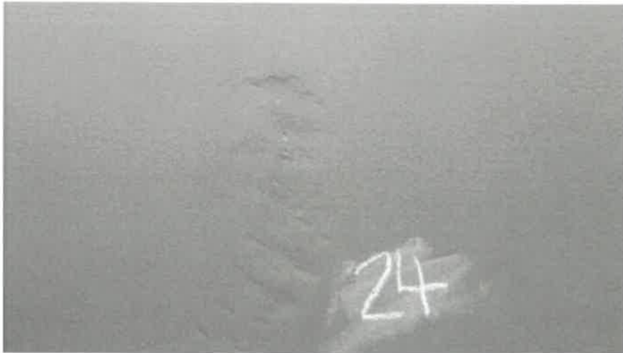
Bild 232 (Übersicht Prüfpunkt 204 mit Schleif- spuren und Kerben in der Oberfläche des Steg- blechs W1)
