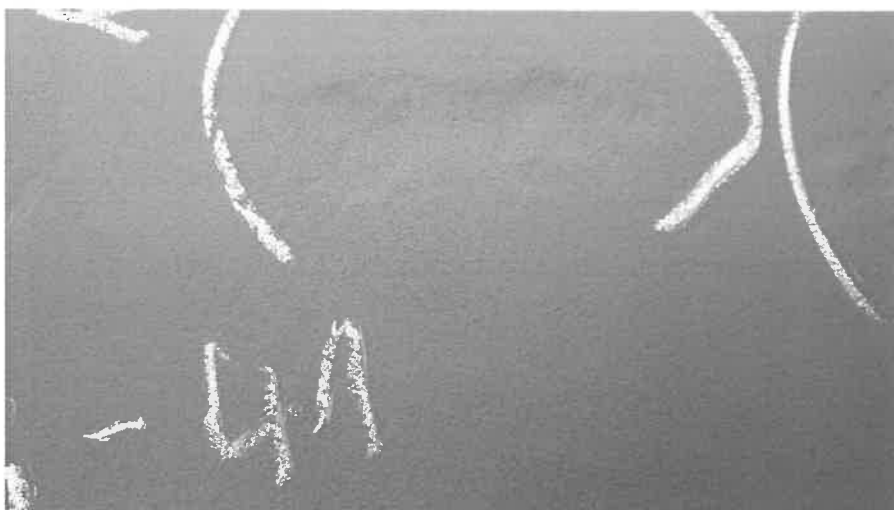
Bild 181 (Detail Prüf- punkt 161)
