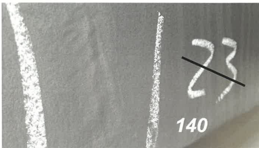
Bild 155 (Detail Prüf- punkt 140 an Stegblech W2)
