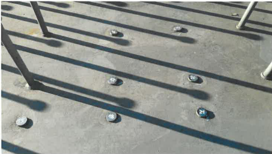
Bild 4 (T34A: Detail Bolzen Nr. 15 bis 21)
