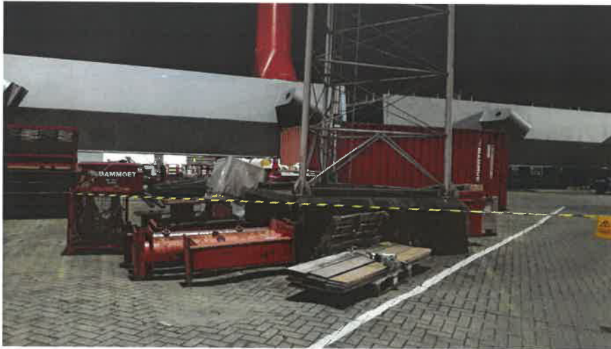
Bild 1 (Ansicht auf die Hohlkästen der Rheinbrücke innerhalb des Sicherheitsbereichs)
