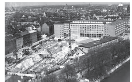
Baugrube des Hochhauses
