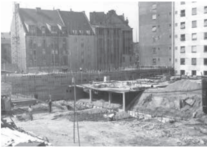
Mai 1956: Baugrube des Südtrakts
