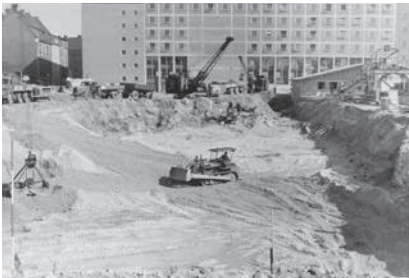
März 1957: Baugrube Nordteil mit Blick auf Neubau Südtrakt
