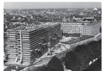
Blick auf die Baustelle des Hochhauses, im Hintergrund der bereits fertiggestellte Atriumbau
