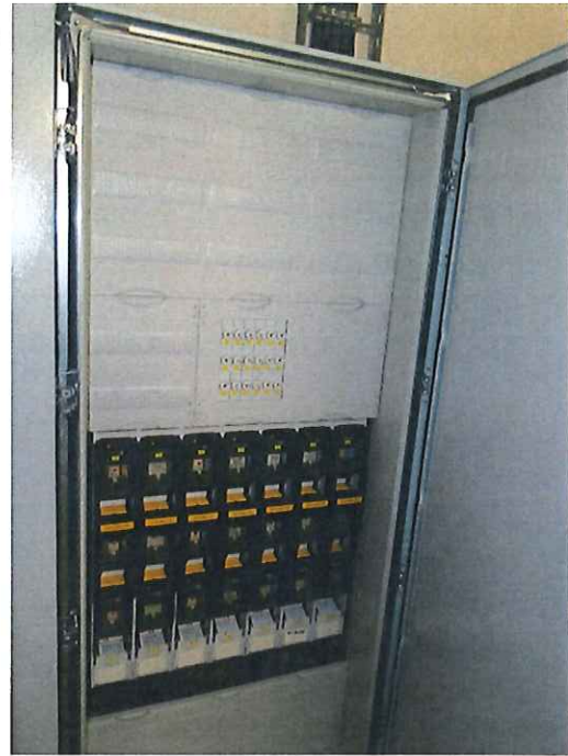
Niederspannungshauptverteilung (NSHV)
