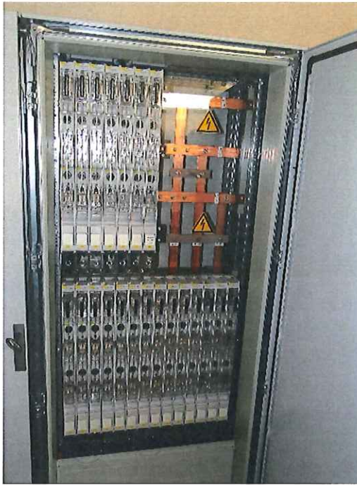
Niederspannungshauptverteilung (NSHV)
