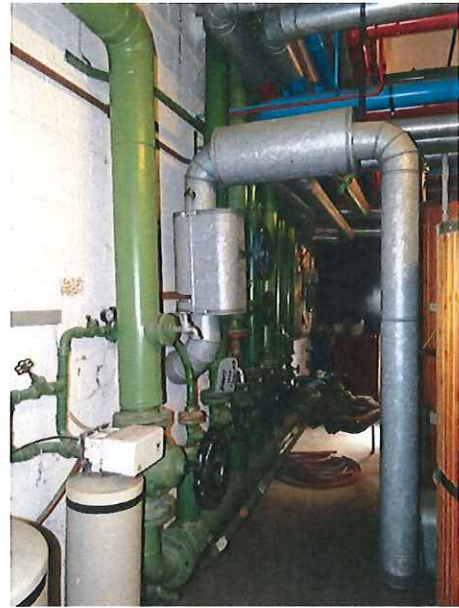
Trinkwasserverteiler
