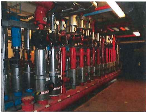
Heizungszentrale – Vorlaufverteiler
