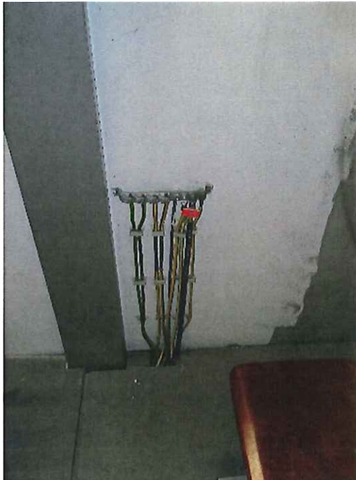
Hauptpotentialausgleichschiene
