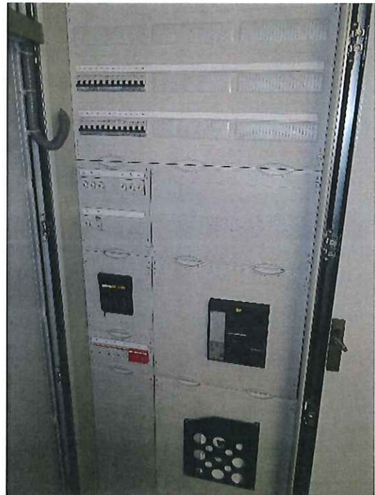
Niederspannungshauptverteilung (NSHV)
