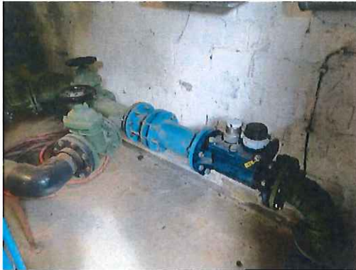
Hauswasseranschluss Trinkwasser
