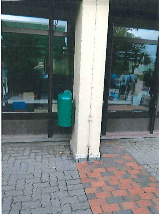
Ableiter Blitzschutz ohne Nummernschild im Außenbereich
