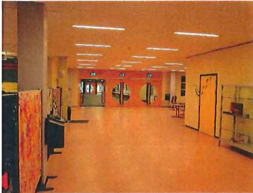
Beleuchtung im EG - Flur
