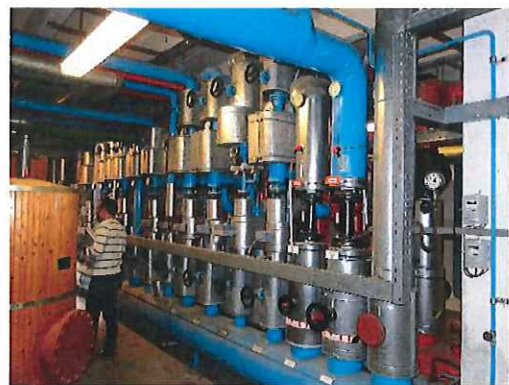
Heizungszentrale - Rücklaufverteiler
