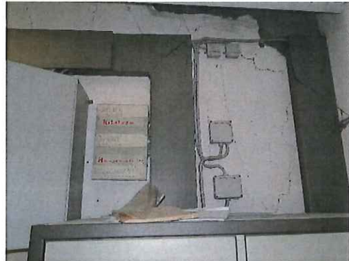
Leitungsinstallation Sicherheitsbeleuchtung im UG, NSHV-Raum
