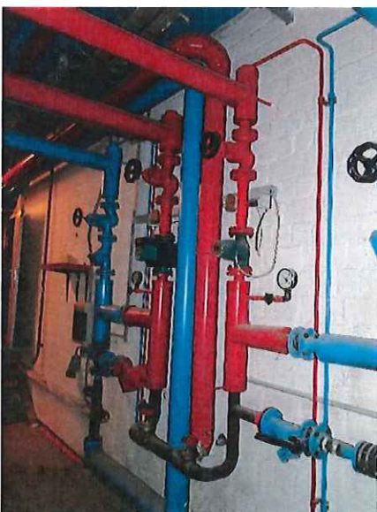
Lüftungszentrale – Sekundärkreislaufbau
