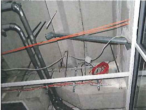
Leitungsinstallation im Deckenbereich 1.OG – Flure
