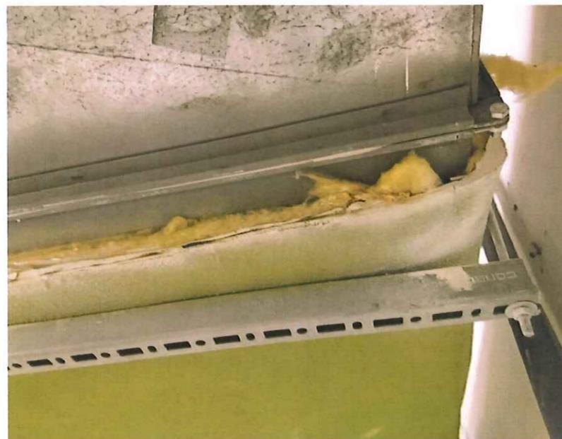
4 ROHRLEITUNGSDÄMMUNG: KMF HINTER GIPSMANTEL (SCHADSTOFF)
