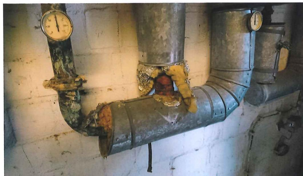
5 DÄMMUNG: KMF HINTER BLECHMANTEL
