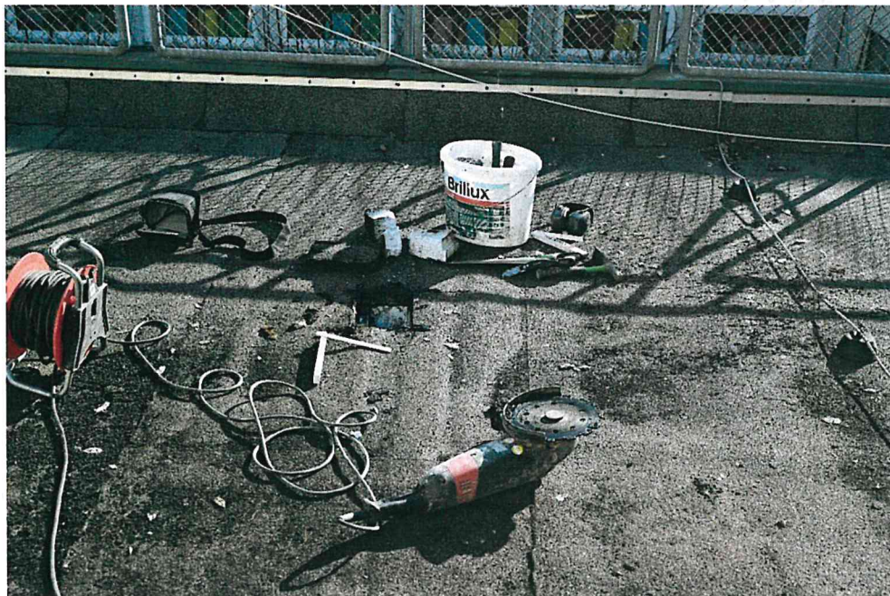
Abb. 4: Flachdach Erweiterungsbau, Flachdach im Bereich der Probenahmestelle D 3
