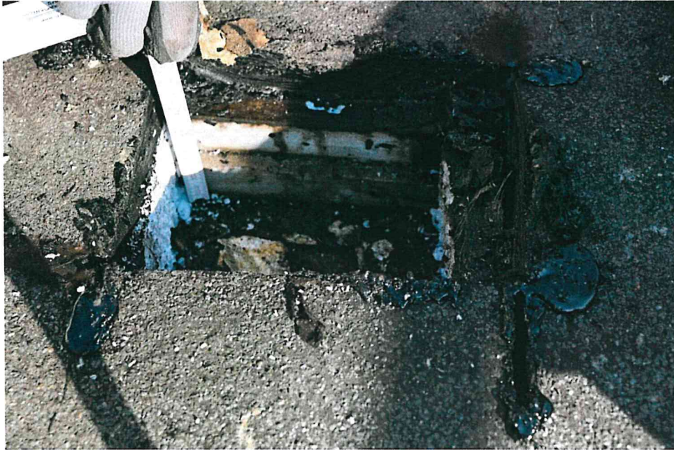
Abb. 3: Geöffnetes Dach am Probenahmestelle D 3:
