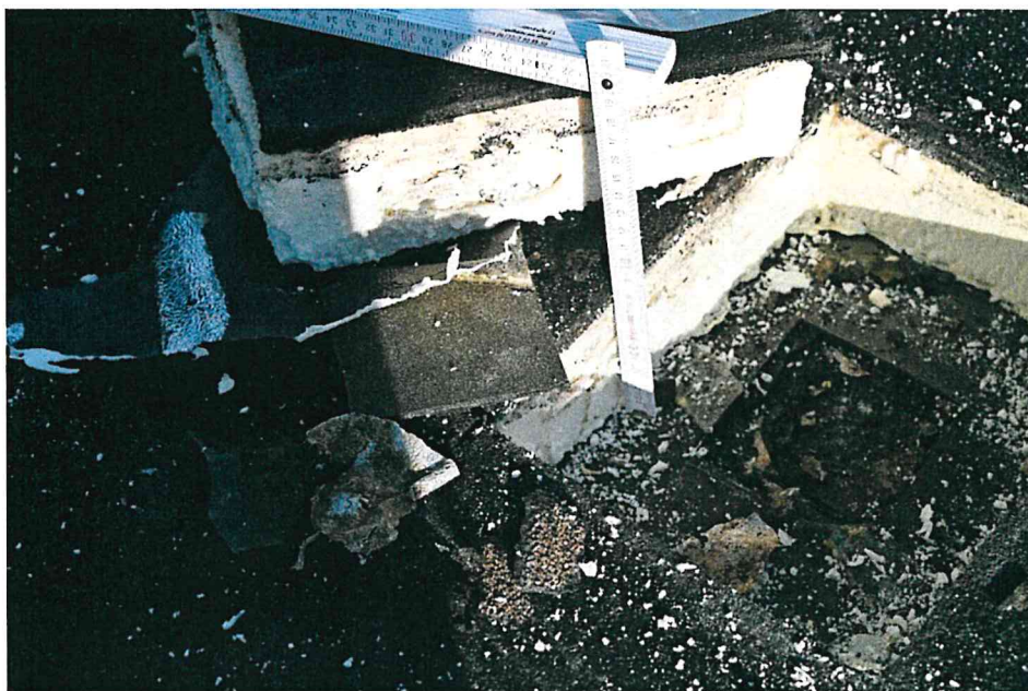
Abb. 2: Geöffnetes Dach am Probenahmestelle D 2:
