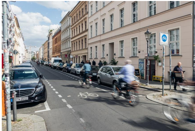
Abbildung 1: Fahrradstraße Liniestraße in Berlin-Mitte mit markierten Sicherheitstrennstreifen zur Türzone der Kfz (Quelle: Eigenes Foto)
