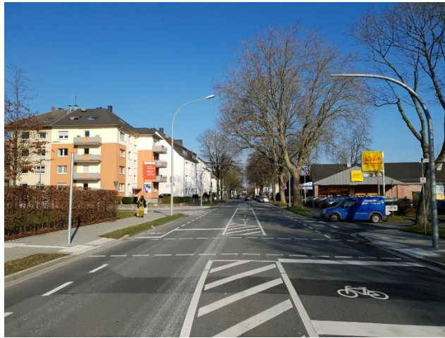
Markierte Querungshilfe an versetzter Einmündung der Giefersstraße und Jahnstraße in die Rathenaustraße. LSA ist vorbereitet (eigenes Foto)
