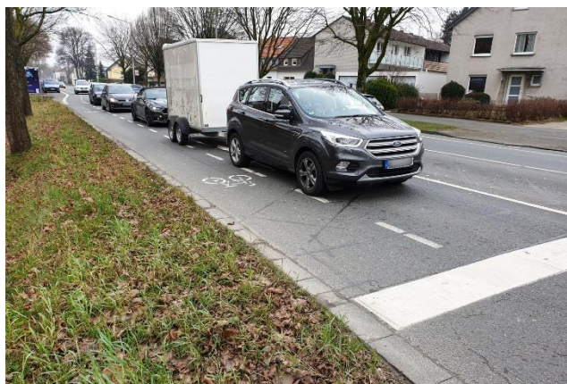
Fehlende vorgezogene Haltelinie am Knotenpunkt Elsener Straße/Bernhard-Hunstig-Straße (eigenes Foto)
