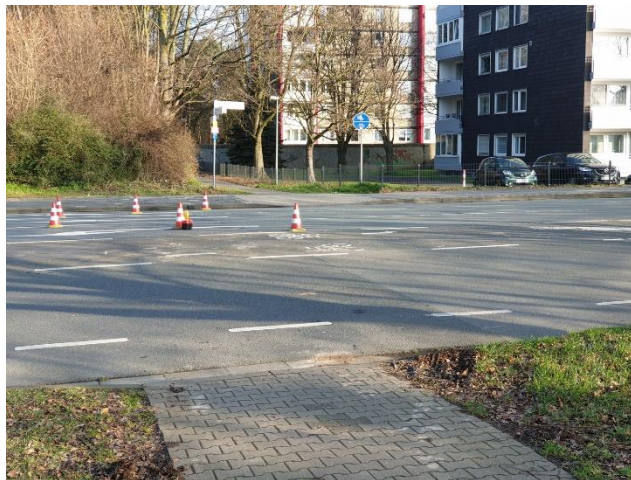
Markierte Querungshilfe für linksabbiegenden und querenden Radverkehr vor der LSA Riemekestraße/Hein-Nixdorf-Straße. Die Querungshilfe ist vom Fahrbahnrand nicht gut zu erkennen und unauffällig (eigenes Foto)
