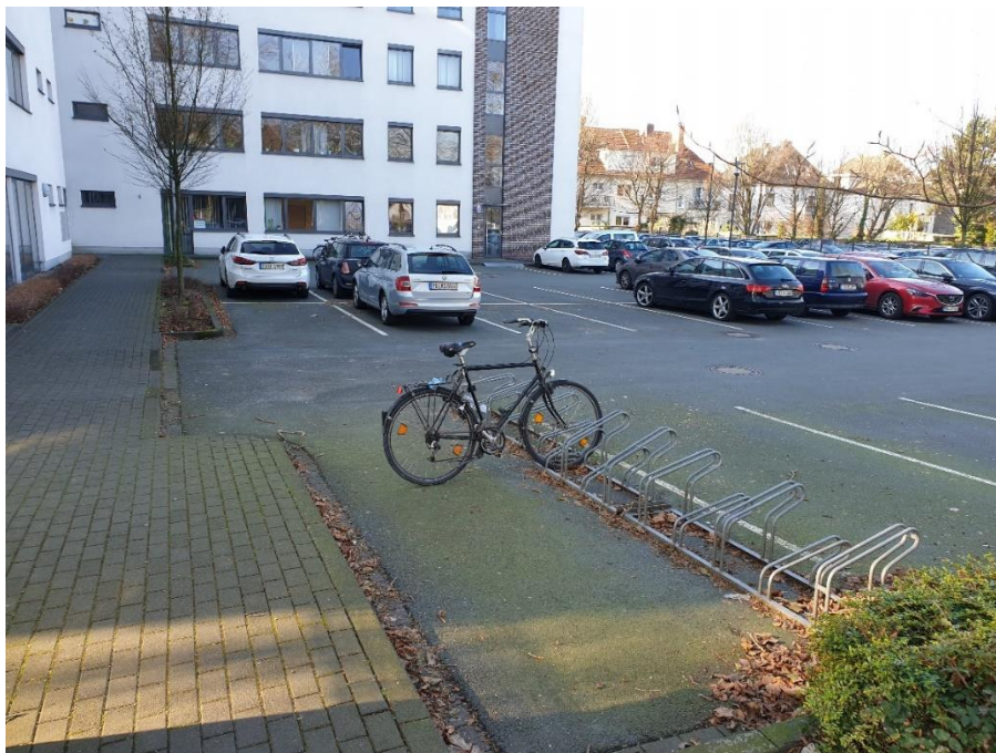
Abbildung 11: Häufig genutzter Anlagentyp im halb-öffentlichen und privaten Raum und nicht mehr anforderungsgerecht: Vorderradhalter.
