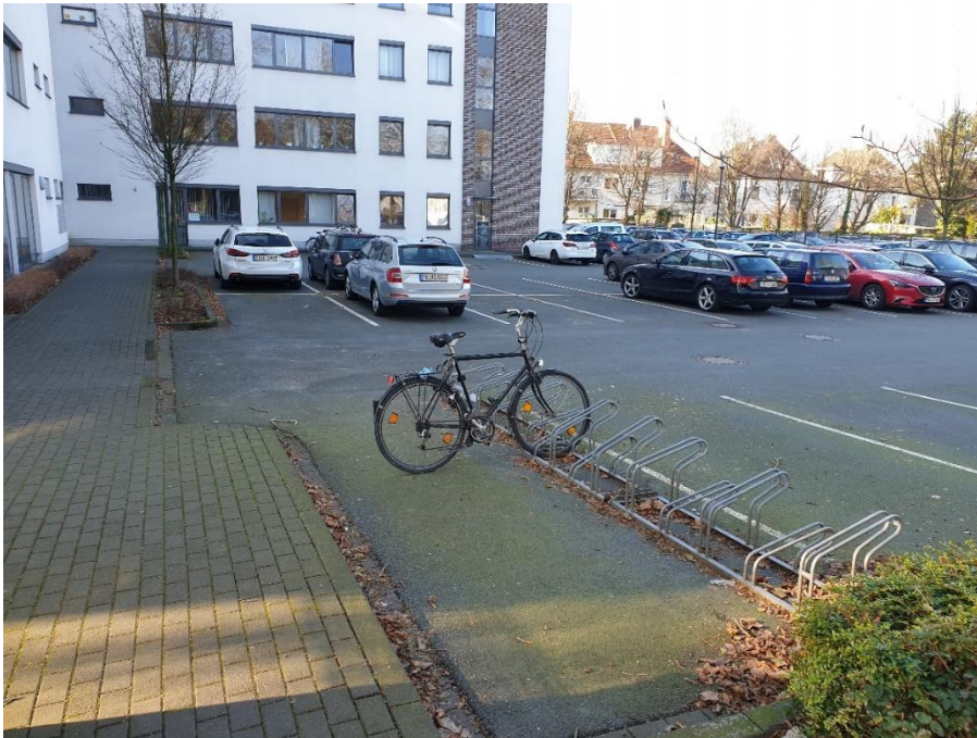
Abbildung 15: Häufig genutzter Anlagentyp im halb-öffentlichen und privaten Raum und nicht mehr anforderungsgerecht: Vorderradhalter.
