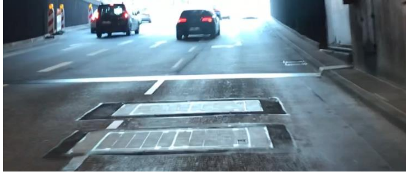
Abbildung 22: Aufnahme der Schächte 52 und 53 im Tunnel
