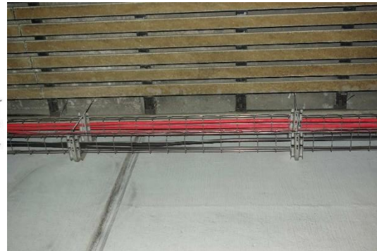
Abbildung 39: Detail von Kappe und Abdichtung (links) und an Tunnelwand geführte Kabeltrasse [10] (rechts)
