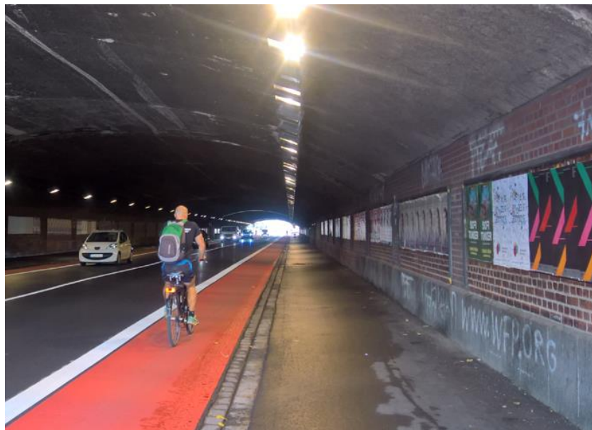
Abbildung 36: Eisenbahntunnel auf dem Klettenberggürtel [24]
