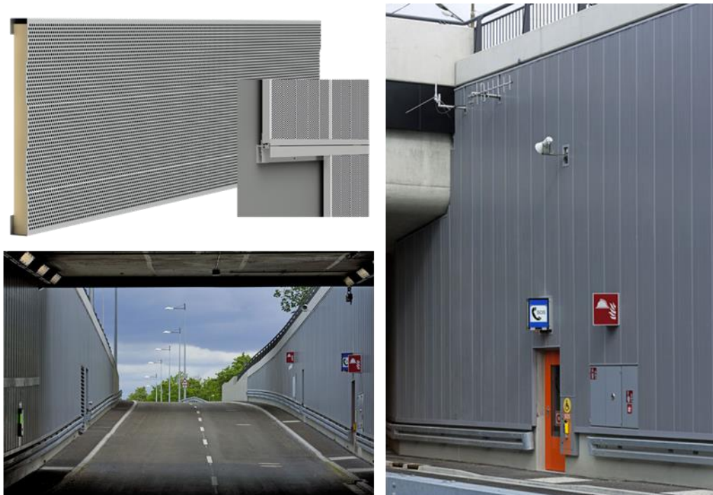
Abbildung 11: Lärmschutzpaneel und fertiger Einbauzustand im Luise-Kiesselbach Tunnel [21] [26]
