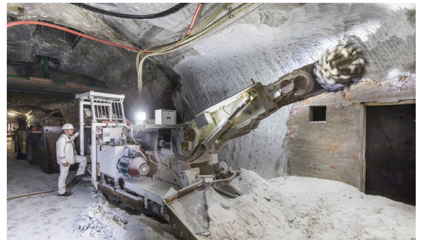
Nachschnitten für den Einbau eines Wettertores (Endlager Morsleben)
