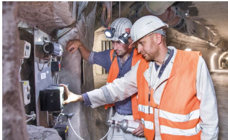
Viktor Schlender, Norman Feige, permanente Überwachung der Grubenwetter (Schachanlage Asse)
