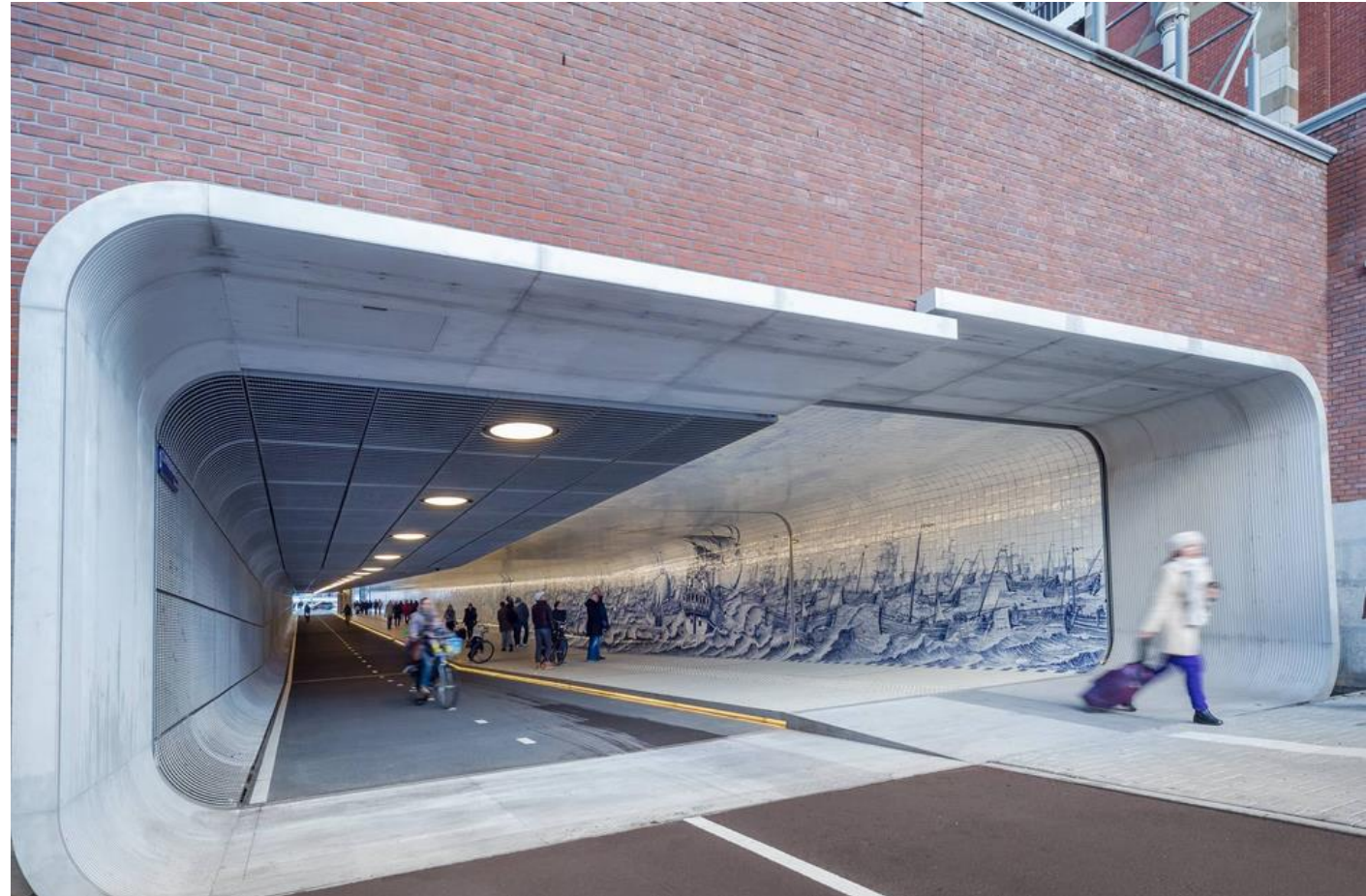
Licht- und Farbtrennung Radweg und Fußweg in der Unterführung am Beispiel Bf. Amsterdam Centraal
