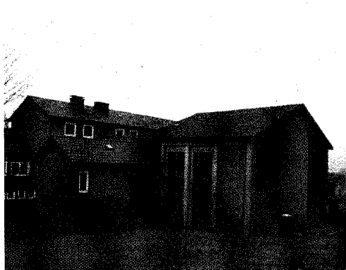
Gebäude B.4 (Kirche u. Sakristei-Anbau)
