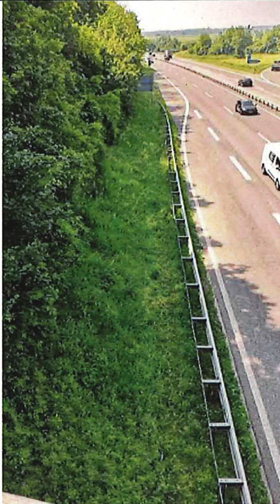
Bild 2 Begehung hinter der Leitplanke bis ca. 400 \mu T Magnetfeld bei Berührung der Leitplanke gemessen
