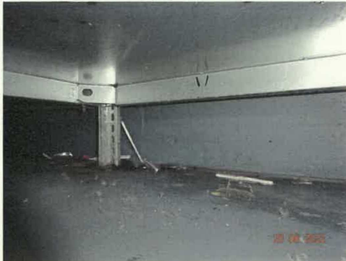
Fußbodenflächen unterhalb der Regale
