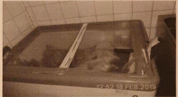
Defekter Deckel der Kartoffelprodukte-Tiefkühltruhe
